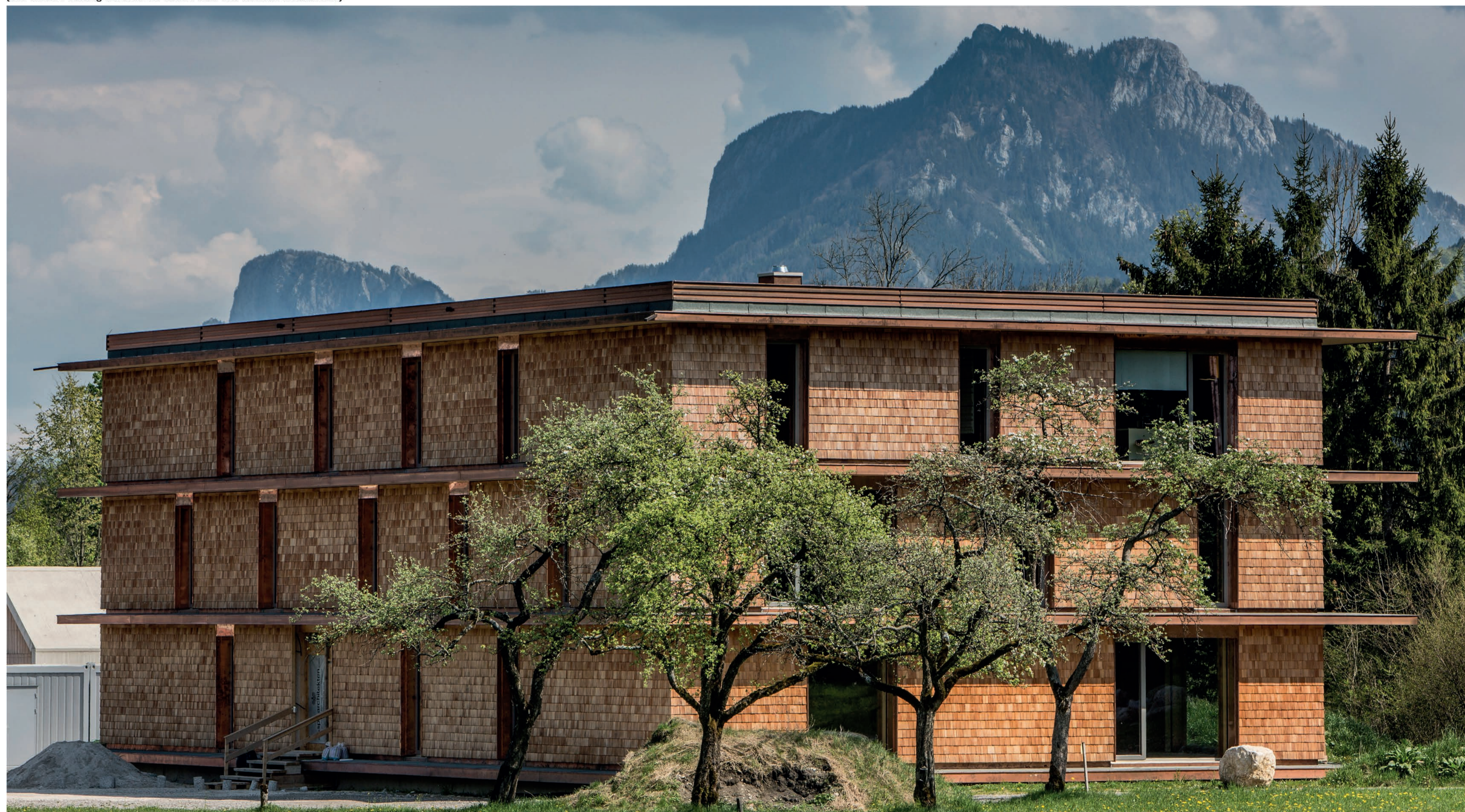
Gesamtansicht von der Nordwestseite
