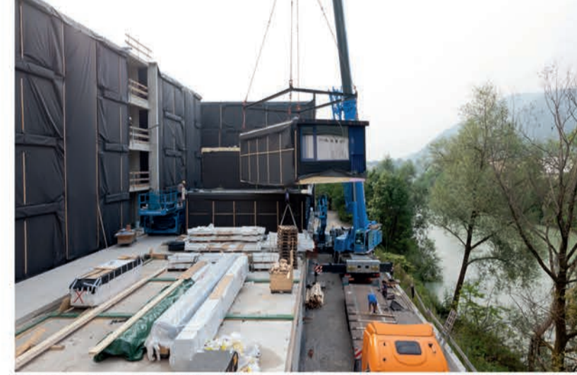
Versetzen der Module
