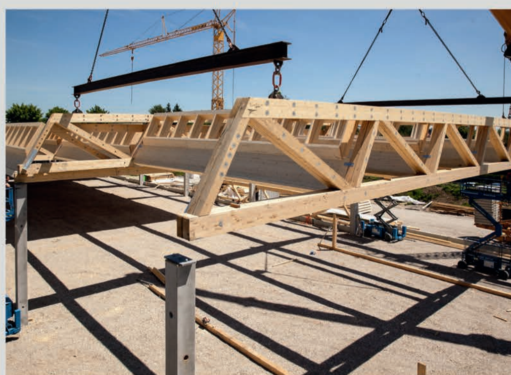
Montage Dachkonstruktion
