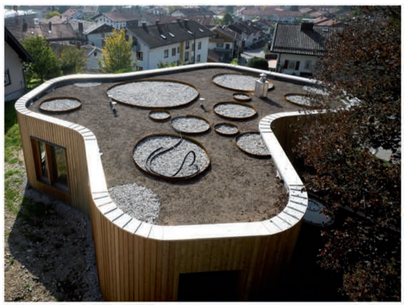
Dachgarten noch unbegrünt mit Anschluss Solarpaneele
