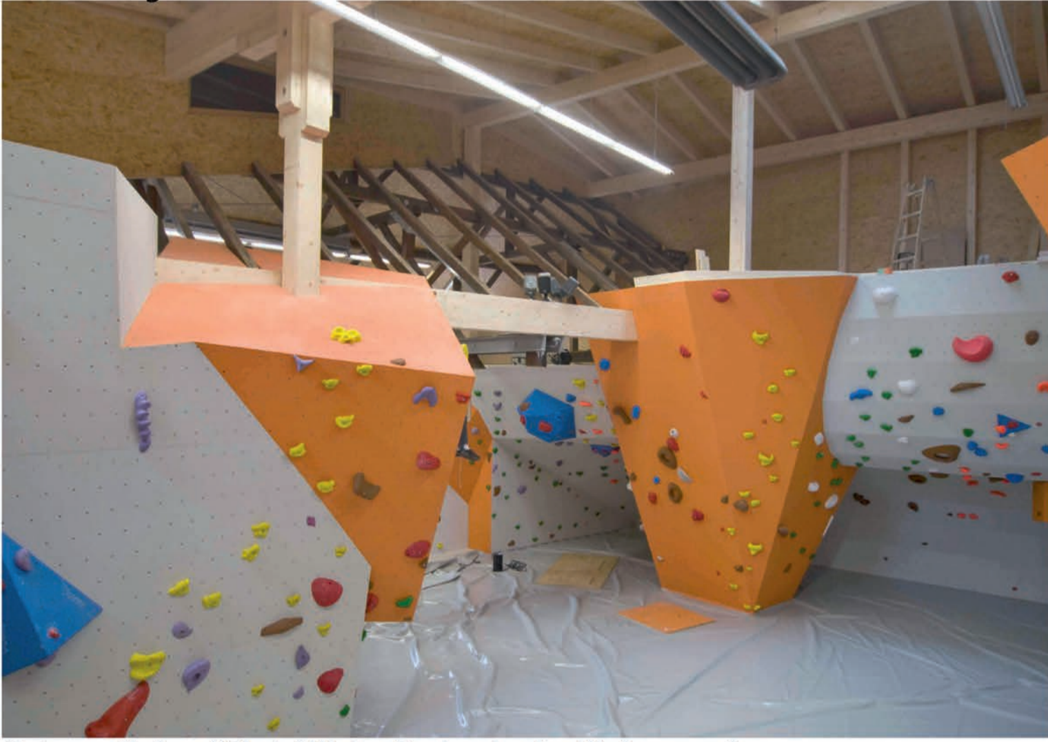
Anbau mit dem "Skelett" des Bestandes im Hintergrund
