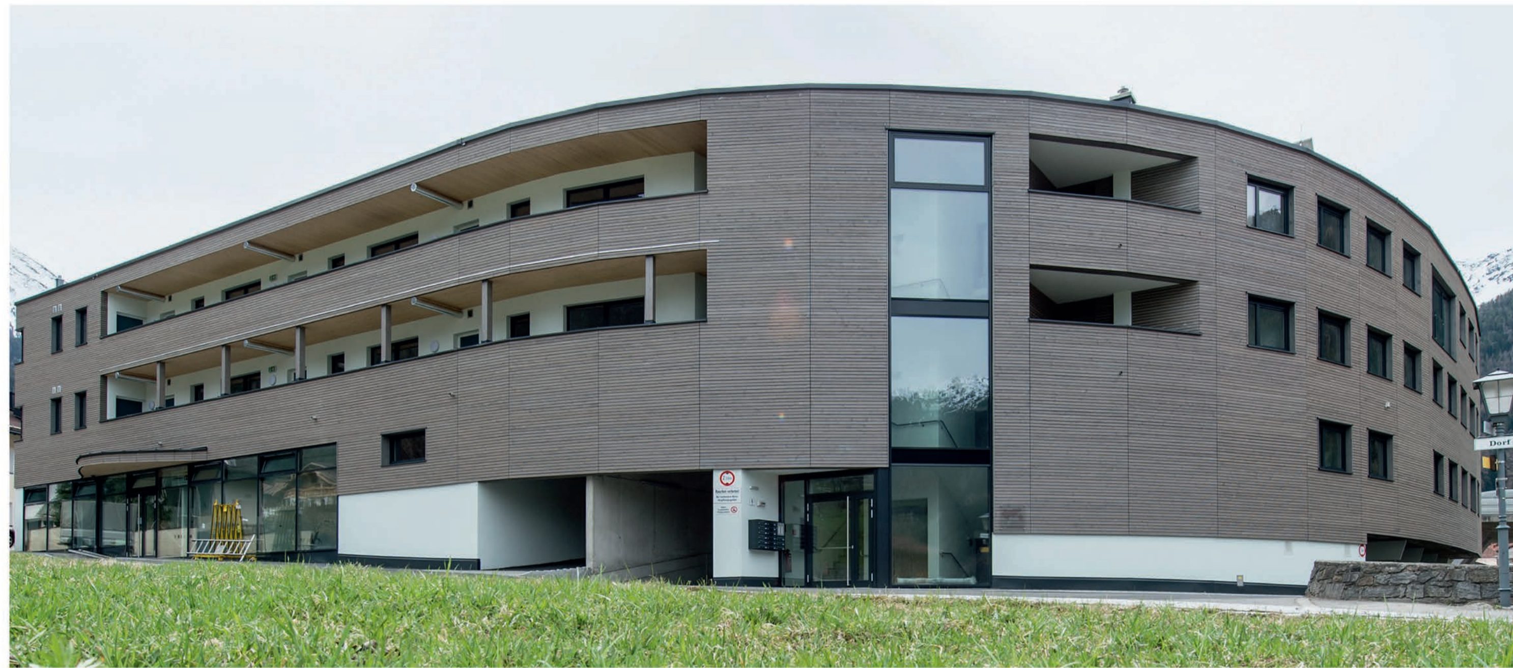
Haupteingang Stiegenhaus / Strassenansicht Nord
