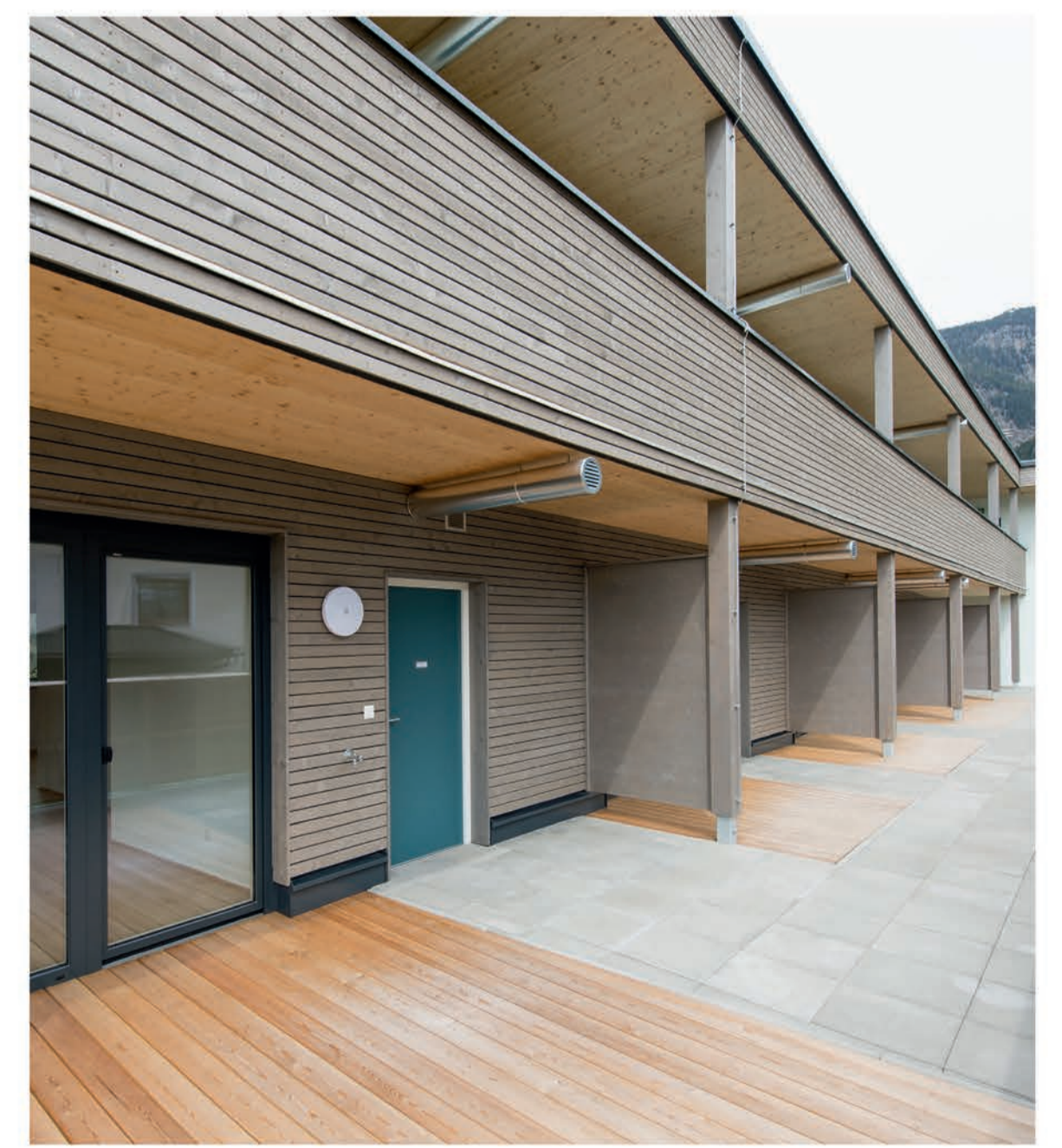
Erschließung Laubengang hofseitig
