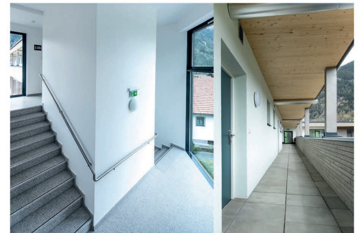
Haupterschließung / Laubengang strassenseitig
