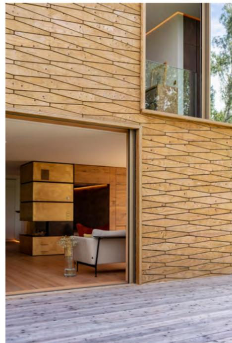
Der Neubau zweier Ferienhäuser entlang des Kanals am Nordufer des Starnberger Sees fügt sich harmonisch in das bestehende Ensemble aus hölzernen Fischerhütten ein. Die vorgehängte, hinterlüftete Holzfassade mit zwei unterschiedlichen Rautenformen erinnert an Fischschuppen. So strahlt der Flachbau trotz der schlichten kubischen Solitäre eine angenehme Wärme aus.
