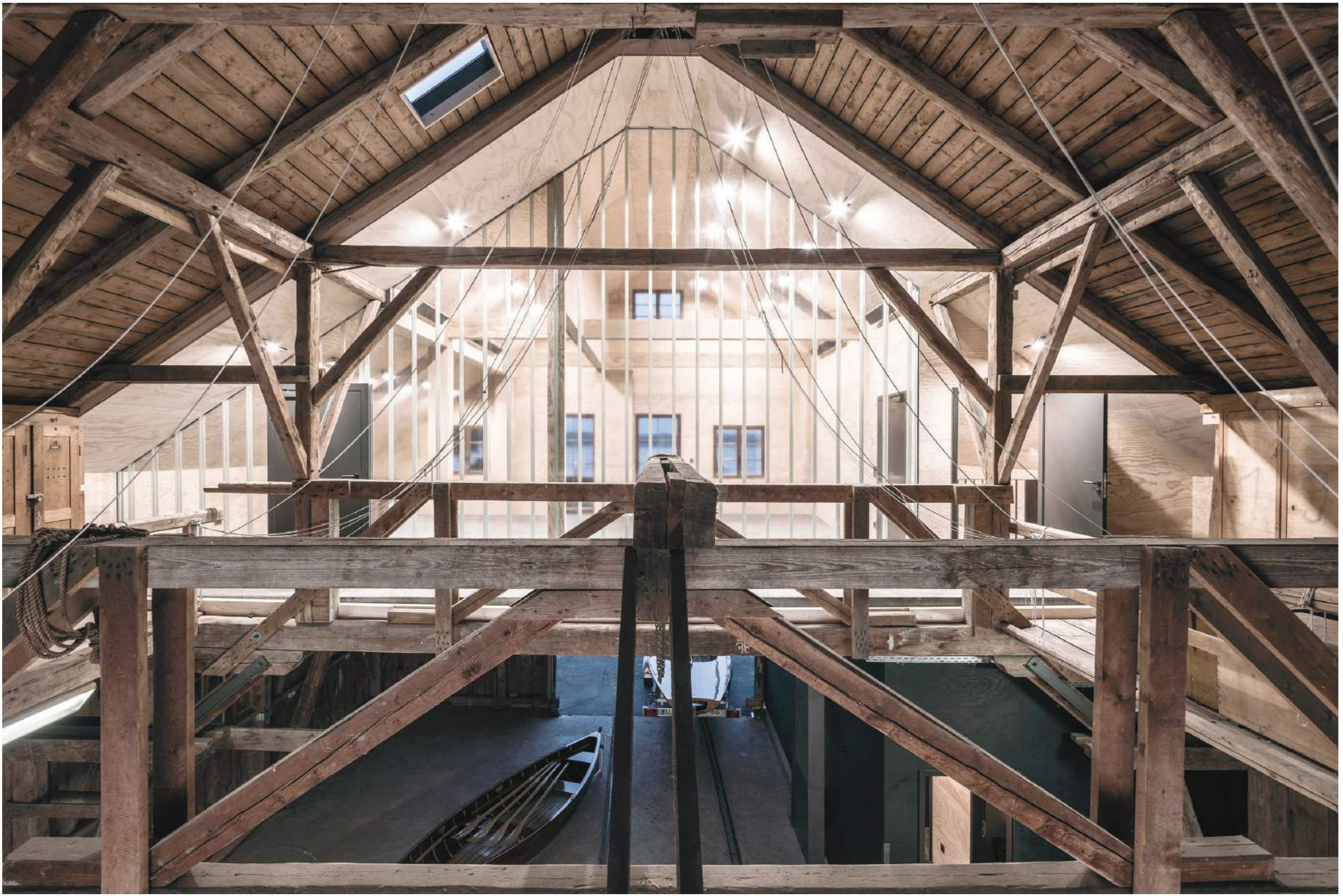
Behutsam wurde der Schulungsraum zwischen der äußeren Hülle und der bestehenden Konstruktion eingesetzt
