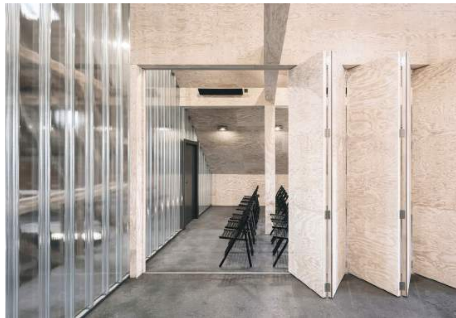
Fallwand im Schulungsraum
