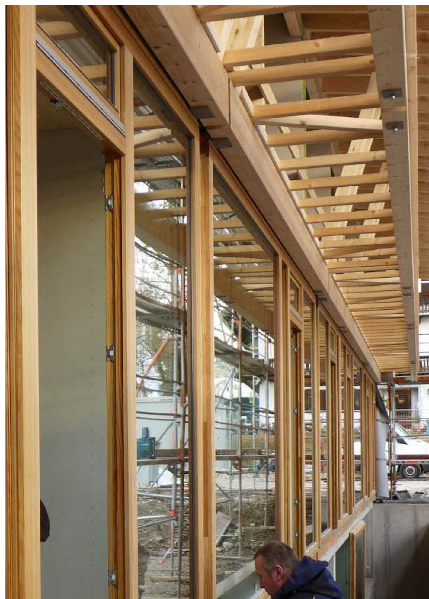
Holzkonstruktion und Holzfassade
