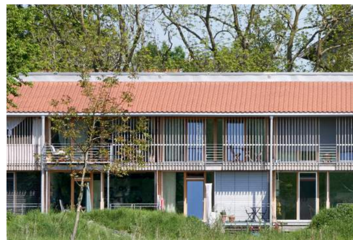
Westansicht von zwei übereinanderliegenden Wohnungen
