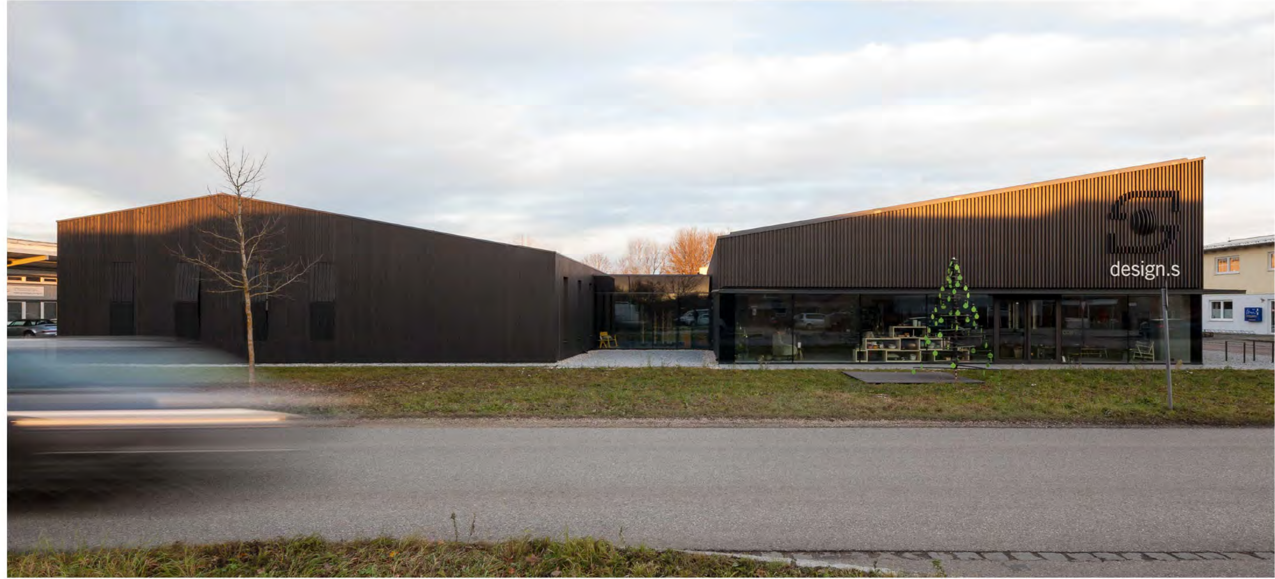
Ansicht von Süd-West
