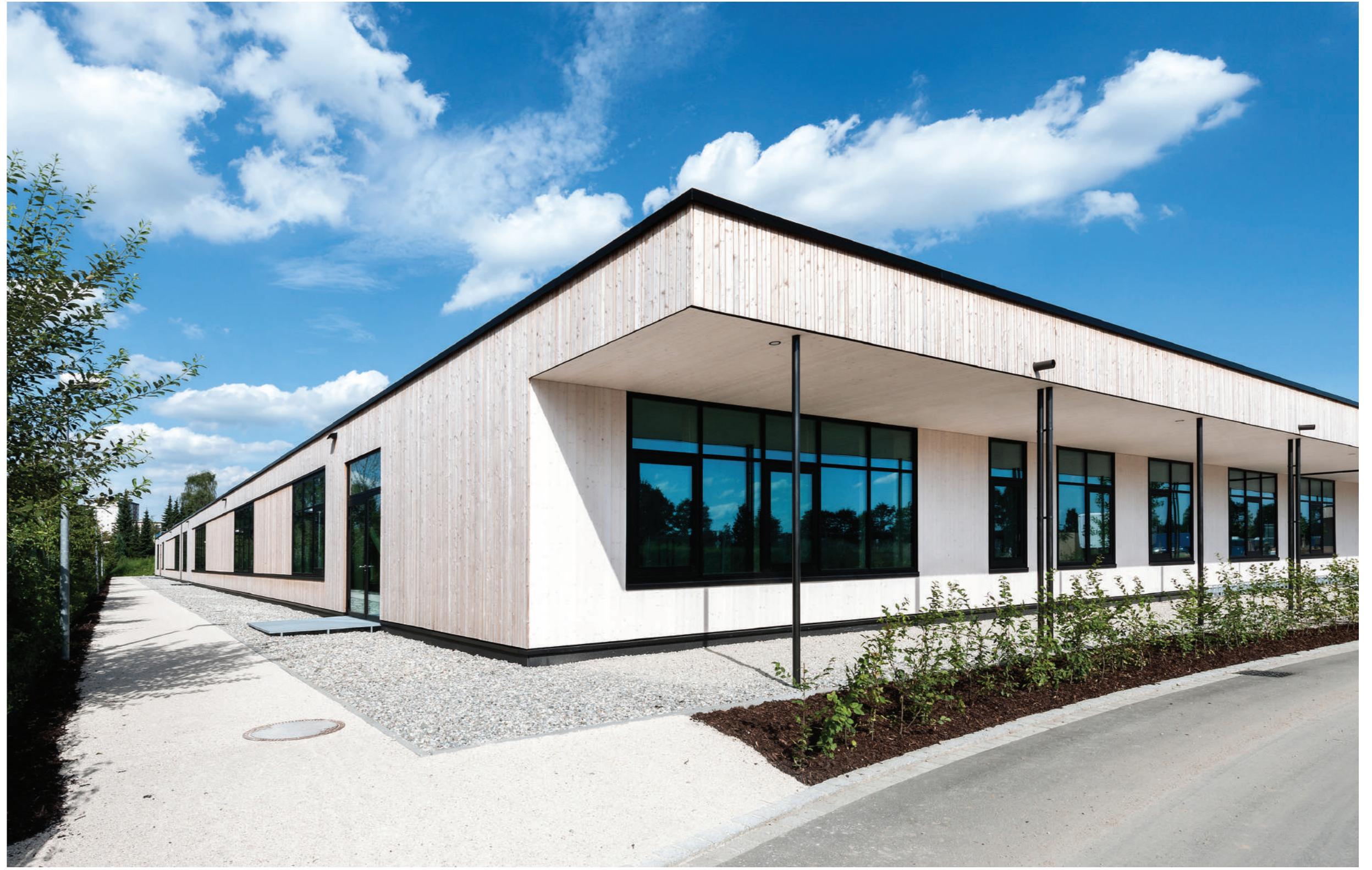
Die Südwestfassade bildet den Auftakt des Gebäudekomplexes.
