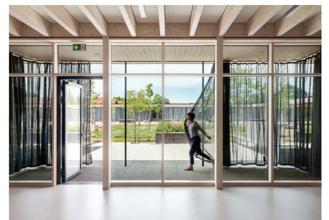
Der Außenvorhang im Innenhof übernimmt den Sonnenschutz.
