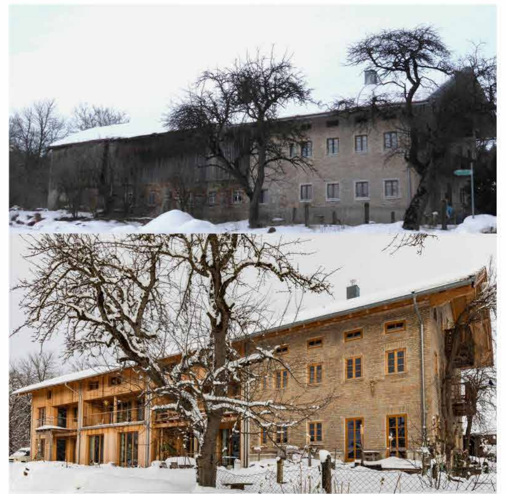
Gabrielhof Bestand (2015) und Sanierung/Neubau (2019)
