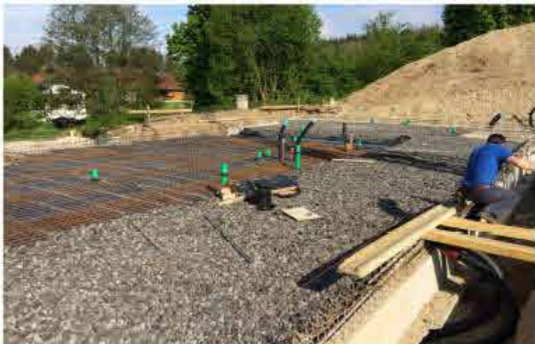
Fundamentarbeiten mit Glasschaumschotter
