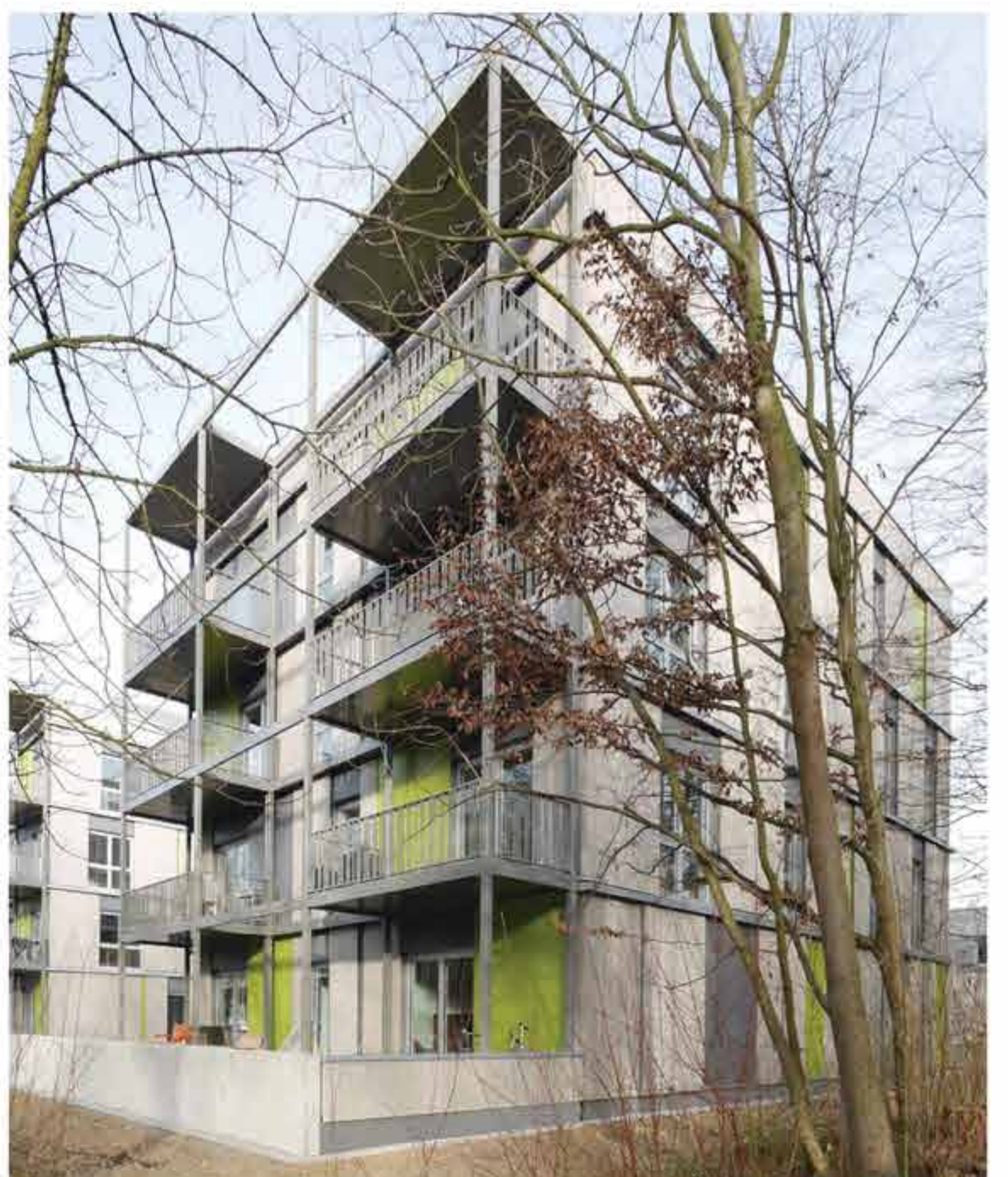
Punkthaus mit Geschosswohnungen
