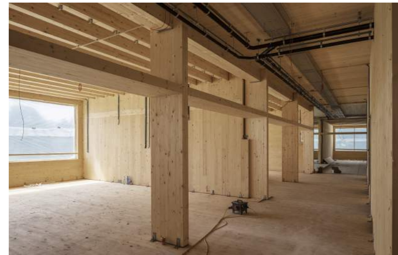
Klassenraum im Rohbauzustand
