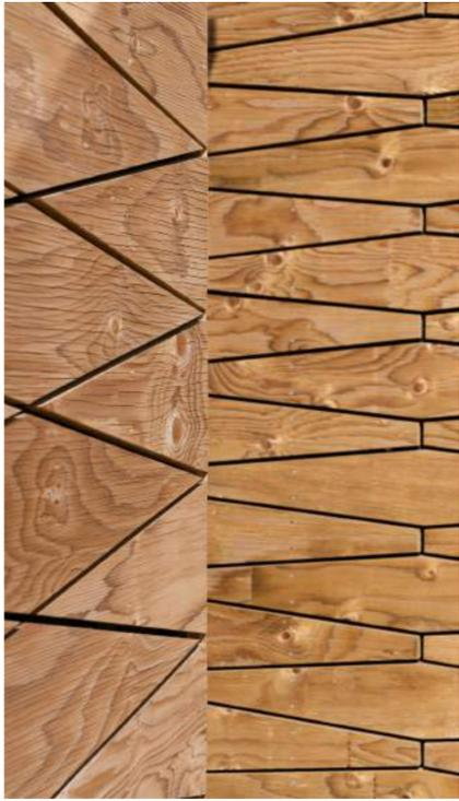
Der Neubau zweier Ferienhäuser entlang des Kanals am Nordufer des Starnberger Sees fügt sich harmonisch in das bestehende Ensemble aus hölzernen Fischerhütten ein. Die vorgehängte, hinterlüftete Holzfassade mit zwei unterschiedlichen Rautenformen erinnert an Fischschuppen. So strahlt der Flachbau trotz der schlichten kubischen Solitäre eine angenehme Wärme aus.
