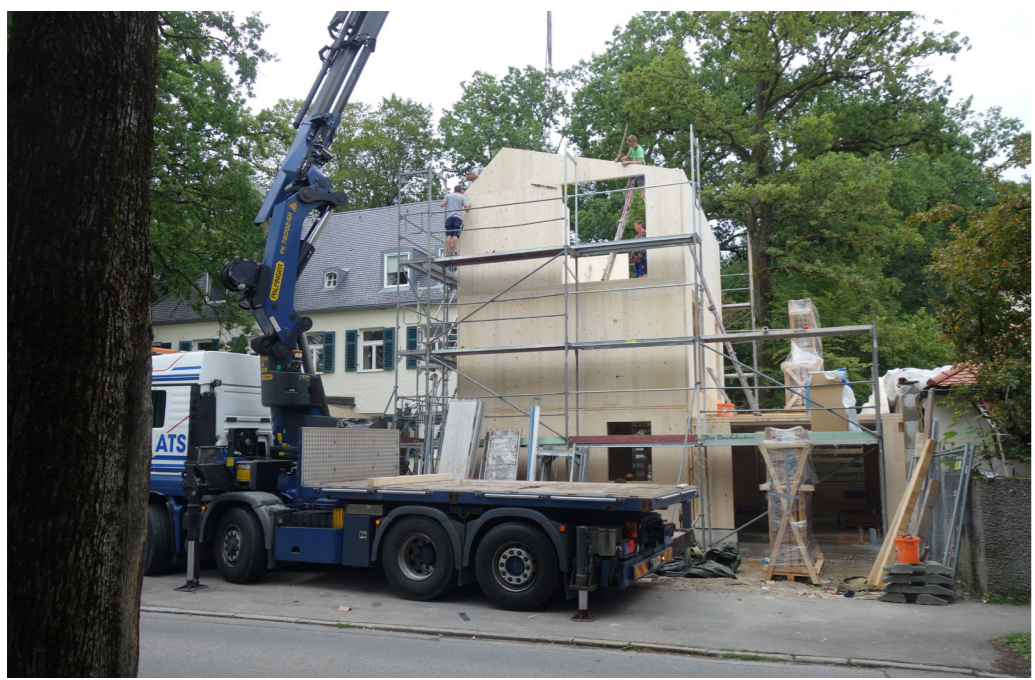
Montage der vorgefertigten Elemente
