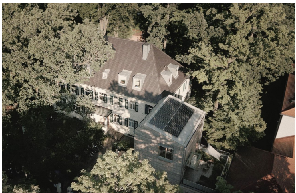
Nachhaltige Energiegewinnung durch Photovoltaikanlage
