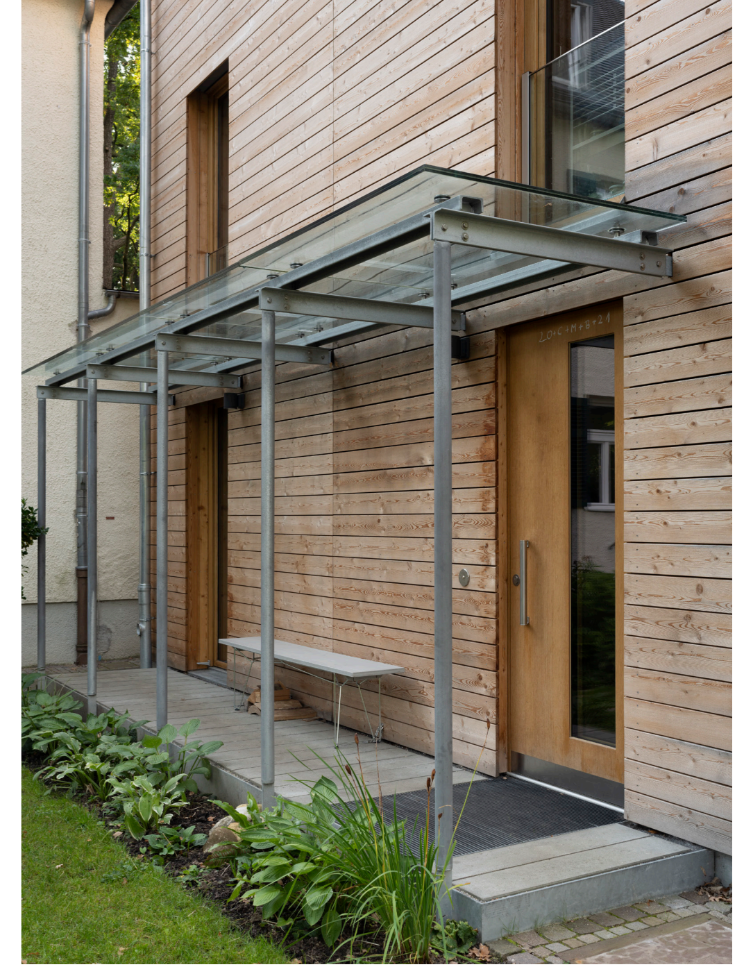
Eingang und Vorbereich
