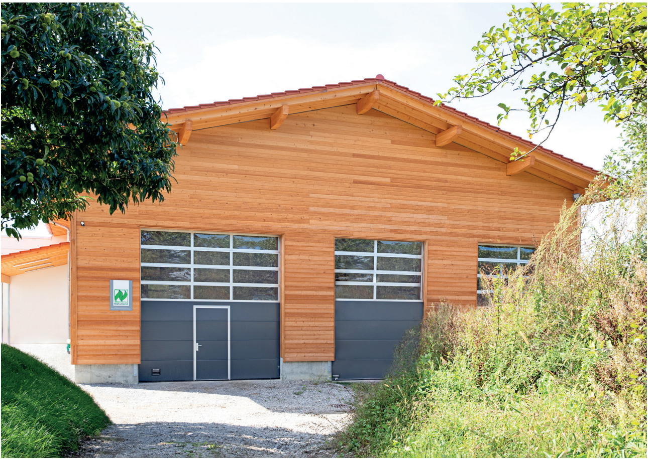
Moderne Scheunentore an der Maschinenhalle.
