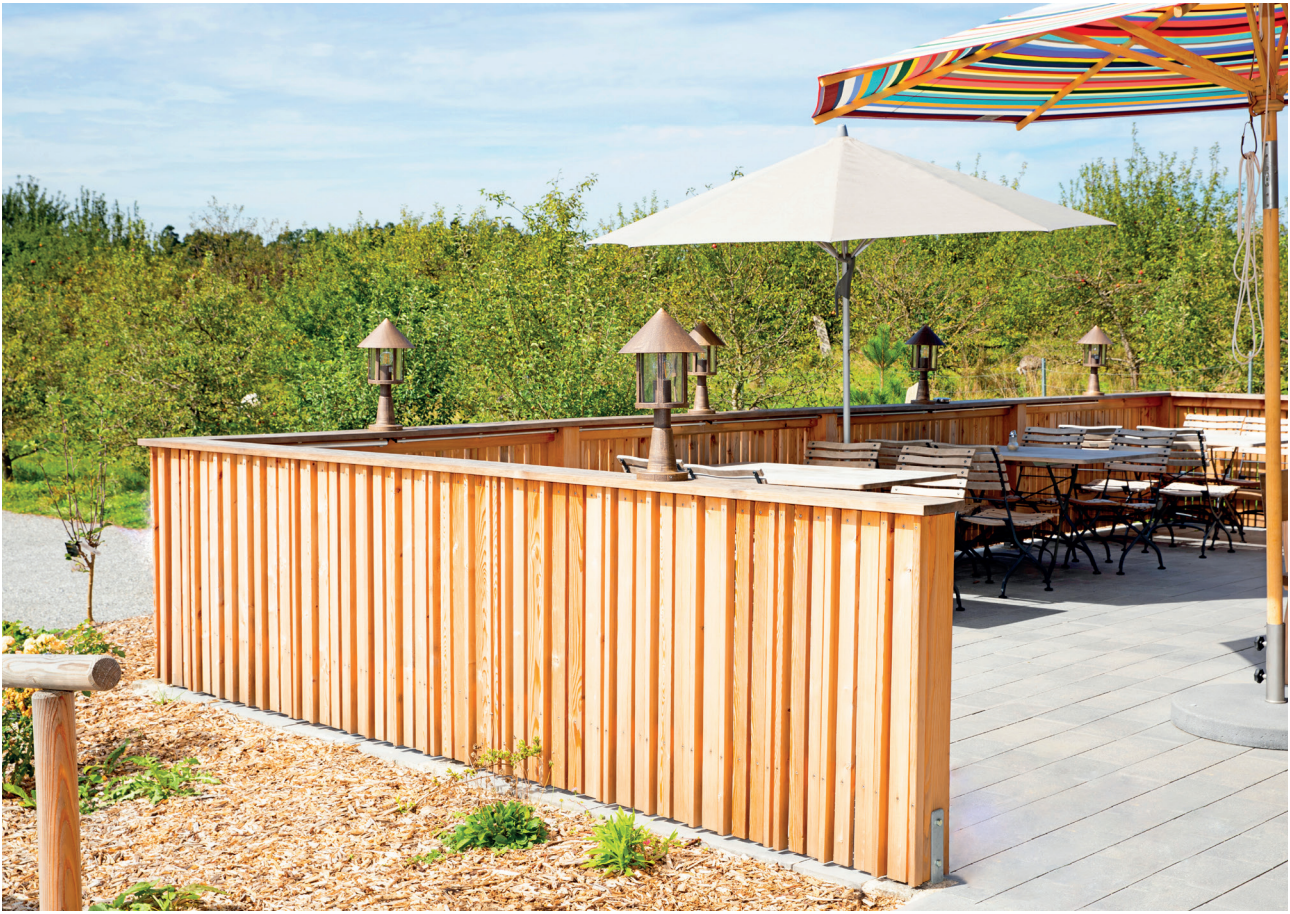
Terrasse mit einem Geländer mit 3D Schalung.
